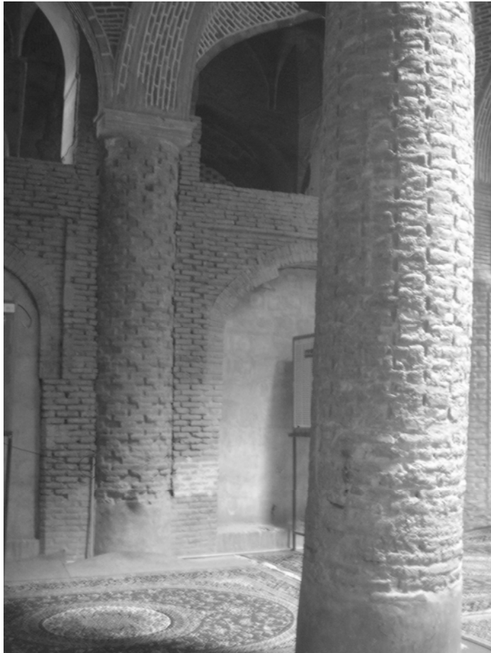
Figura 40 - Masjed-e Jom'eh di Esfahan: sala della preghiera S-E, colonne di fase buyide (sx) e selgiuchid (dx)(foto dell'autore. Settembre 2008)
