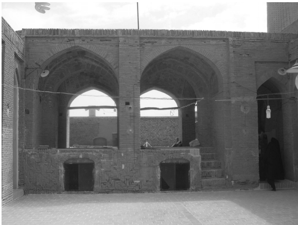
Figura 75 - Masjed-e Pā Menār di Zavare: corte, prospetto E (foto dell'autore. Settembre 2008)
