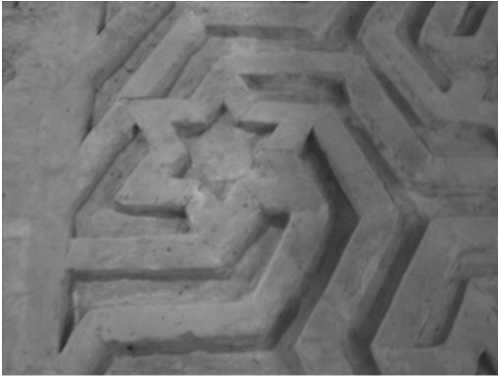
Figura 48 - Masjed-e Jom'ā di E sfahan: gonbadkhāne N ( Gonbad-e T āj al-Mol k) , particolare decorazione in laterizio (foto dell'autore. Settembre 2008)
