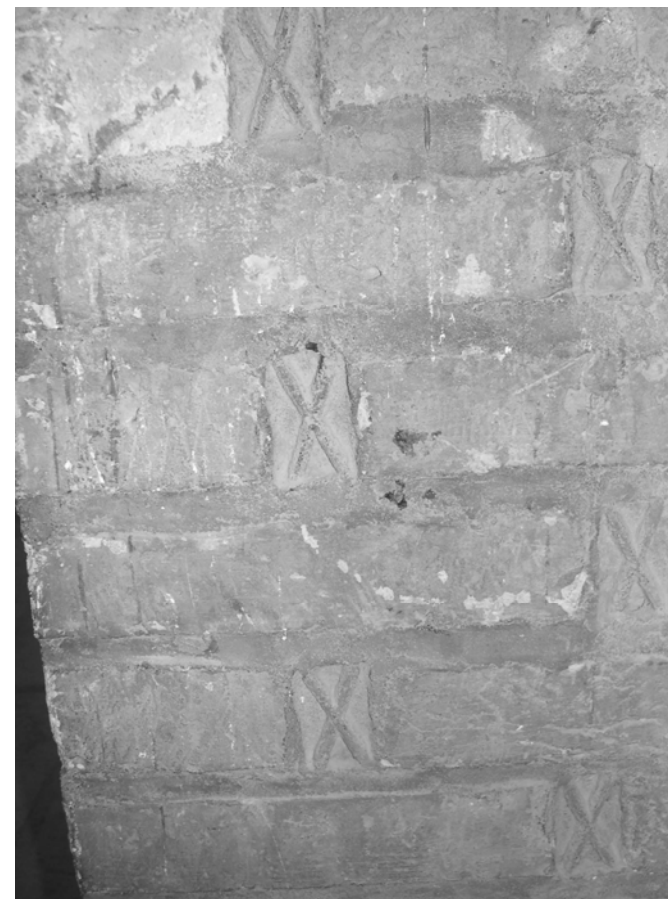
Figura 43 - Masjed-e Jom ca di Esfahan: gonbadkhāne N ( Gonbad-e Tāj al-Molk ), giunti verticali con tasselli in stucco(foto dell'autore. Settembre 2008)
