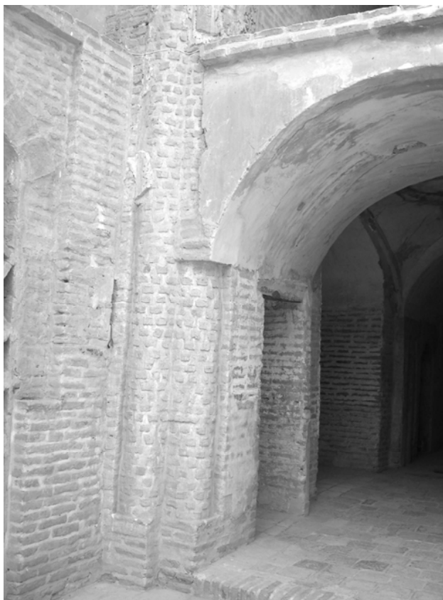
Figura 15 - Masjed-e J āme c di Ardestan: particolare dell'angolo S-O della corte con evidenze della colonna di fase buyide (foto dell'autore. Settembre 2008)
