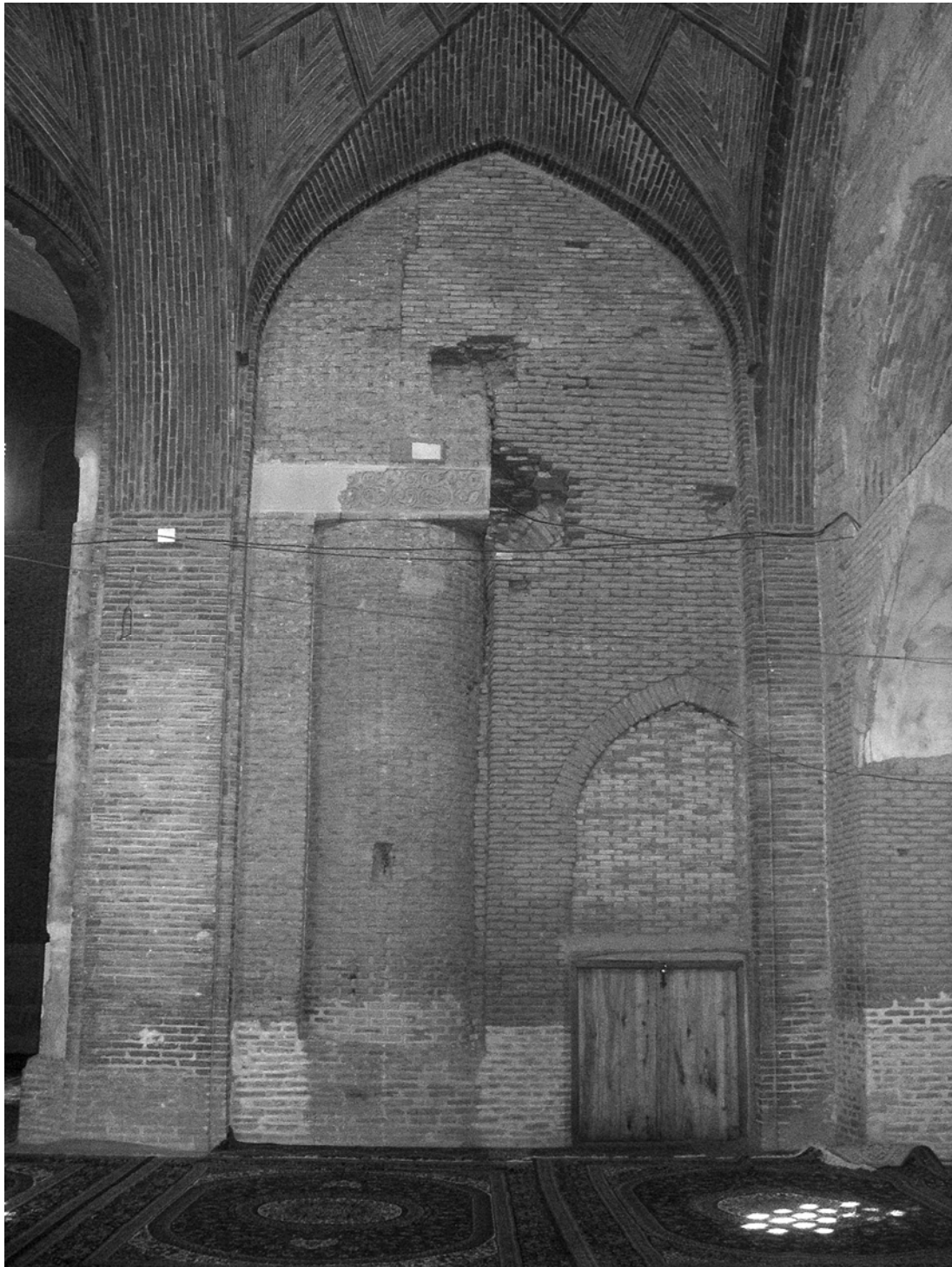
Figura 37 - Masjed-e Jom'eh di Esfahan: sala della preghiera S-E, evidenze del prospetto E della gonbadkhāne S cui sono costruite in appoggio le volte dello shabestān e l' eyvān S (foto dell'autore. Settembre 2008)
