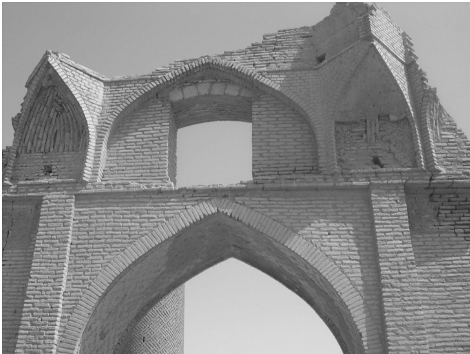
Figura 52 - Masjed-e Jāmeʿ di Gar: gonbadkhāne , evidenze della zona di passaggio (foto dell'autore. Settembre 2008)
