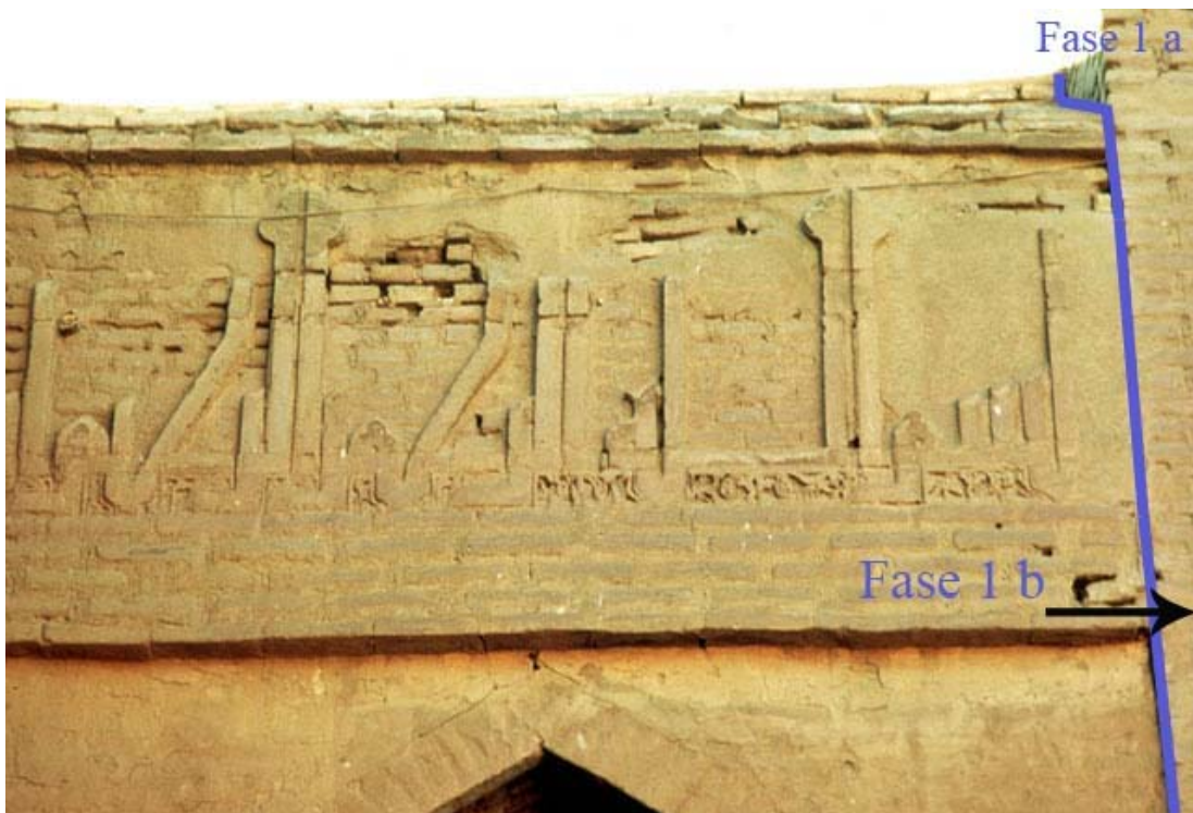
Figura 10 4 - Masjed-e J āme c di Z avare: rapporto tra eyvān , rifianco dell'arco e cornice della corte (tratta da www.archnet.org , autori Blair e Bloom, 1984, conservata presso l'Aga Khan Visual Archive, MIT)
