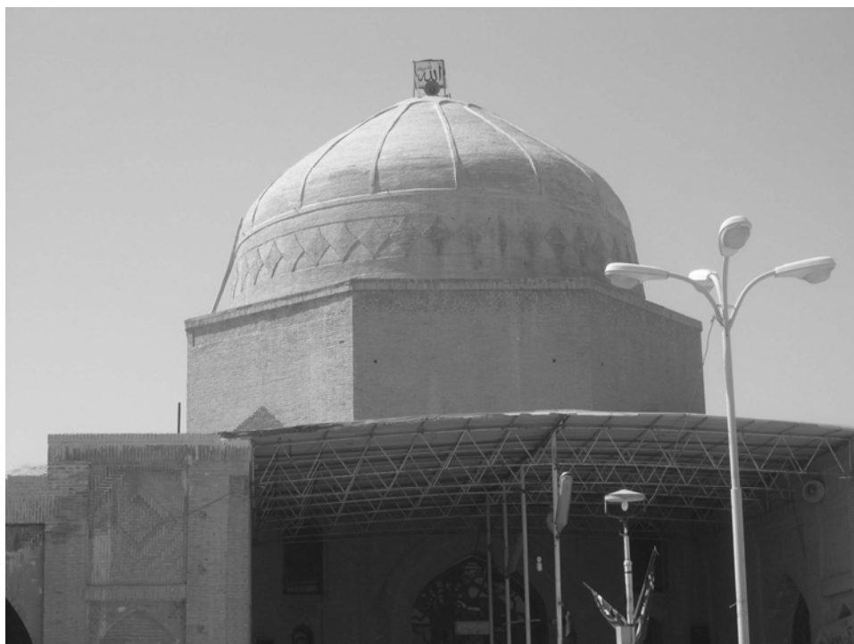
Figura 59 - Masjed-e J āme' di Golpayegan: estradosso della cupola (foto dell'autore. Settembre 2008)
