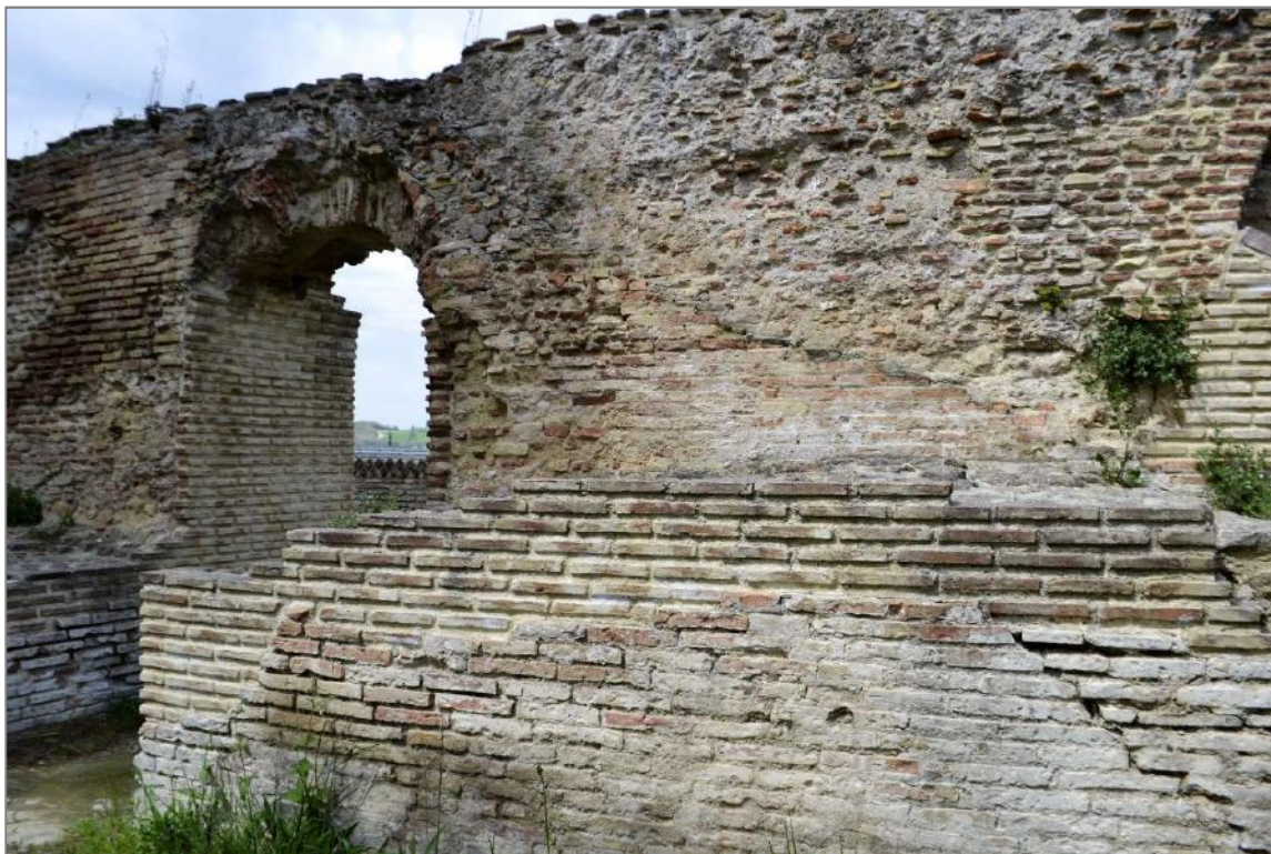
Fig. 23 Particolare della muratura (foto dell'autore)
