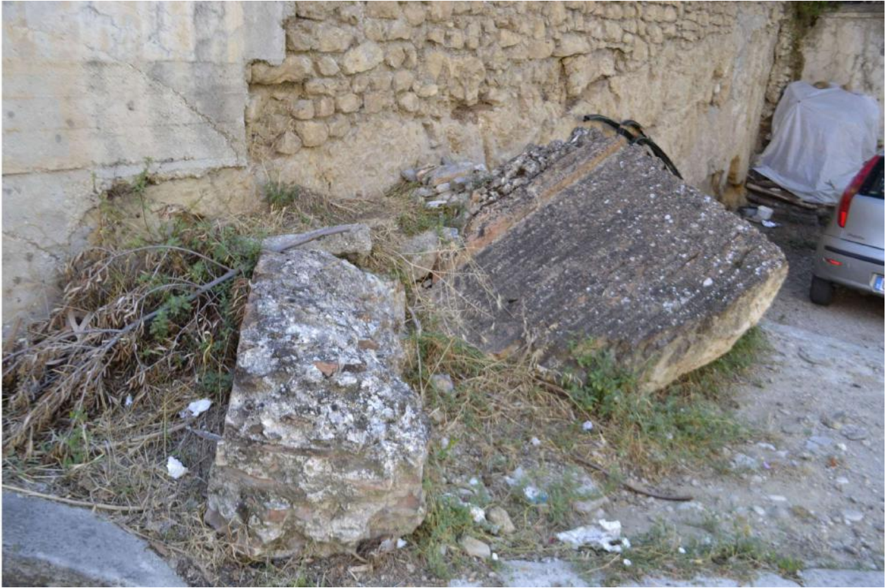
Fig. 24 Elemento strutturale forse parte della porta della città (foto dell'autore)
