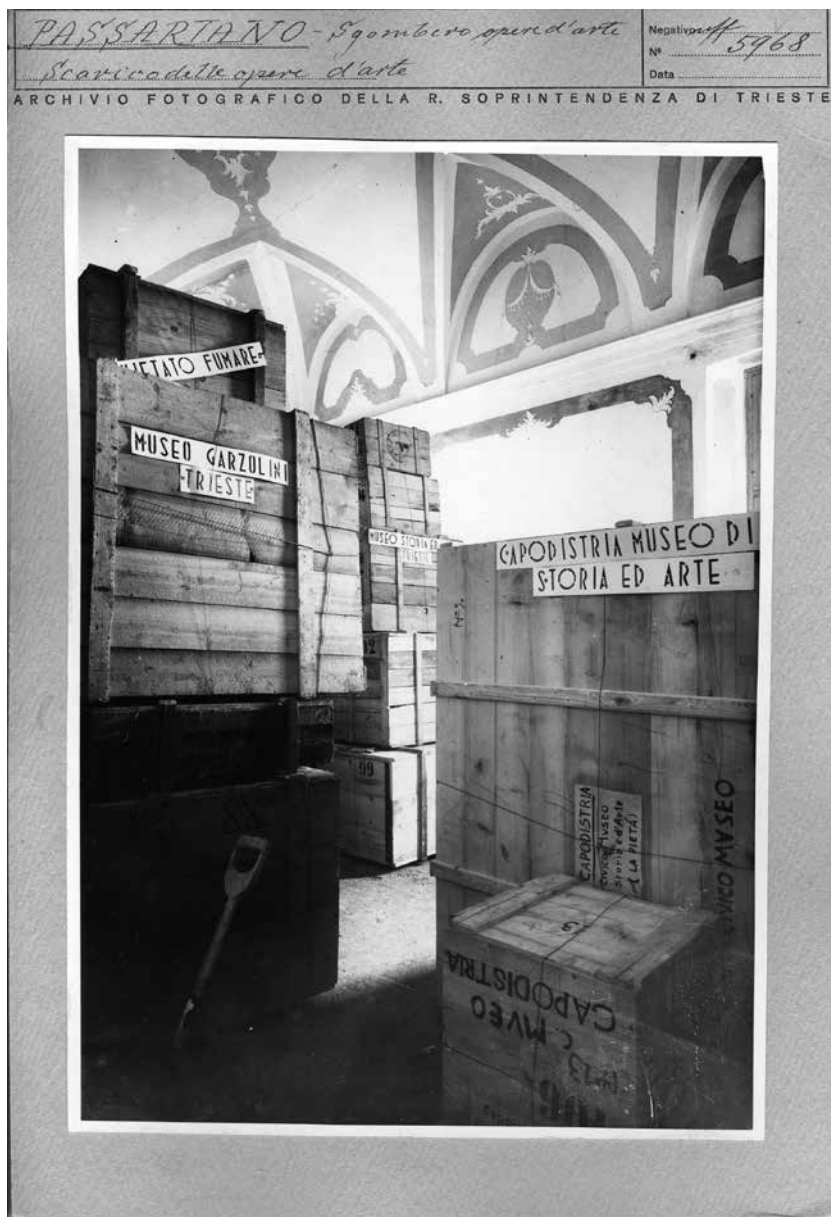
Fig. 14 Ricovero di protezione antiaerea a Villa Manin Passariano (UD), 1940. Archivio Fotografico, allora Regia Soprintendenza di Trieste, su concessione del MiC - Soprintendenza ABAP del FVG.
