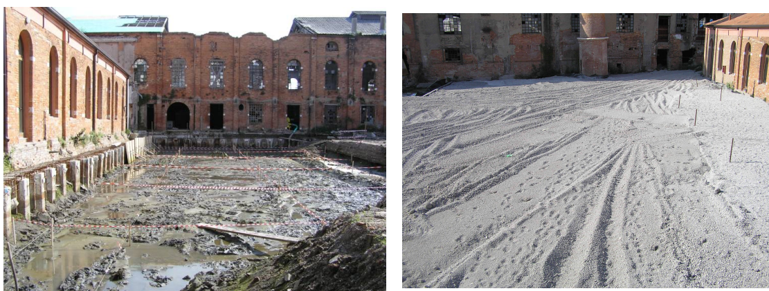
Fig. 3.27: foto dei parte dell'area interessata dal progetto dimostrativo dopo lo scavo (a sinistra) e dopo riempimento con granulato( a destra)
