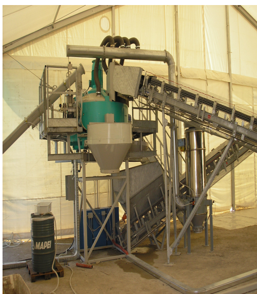
Fig. 3.15: Tramoggia di carico del terreno e miscelatore intensivo dove vengono direttamente dosati il cemento e gli additivi.
