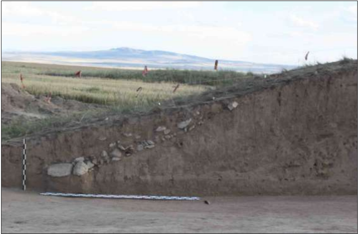
Fig. 29 Basamento in pietra (L5) che riveste la parte bassa del tumulo (lato Est) (foto di G. Bazarbaeva)
