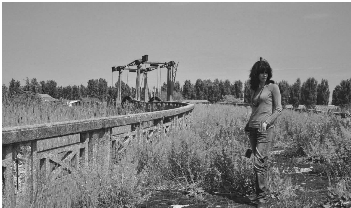
Figura 1. Ponte dei Pesi, Cona-Cavarzere (Ve). Tra manufatti della bonifica durante un'escursione di studio nel Basso Veneto nel 2012 (fotografia dell'autore).
