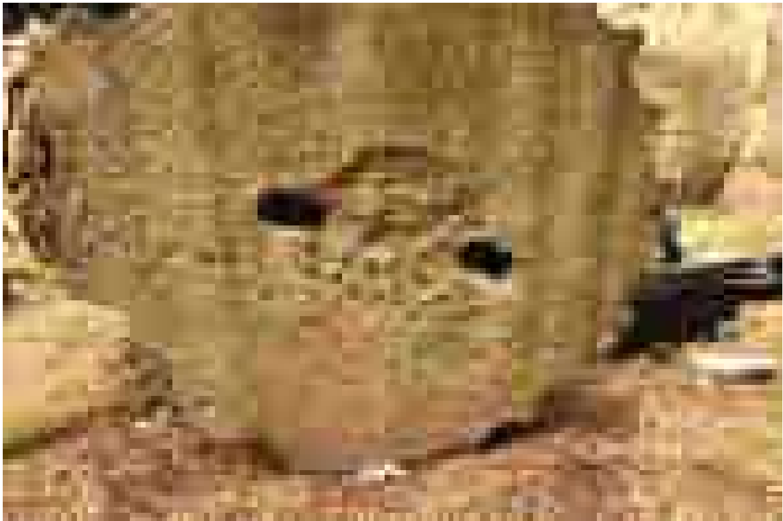
Figura 67: rocchio esterno, fori di giunzione per i perni.
