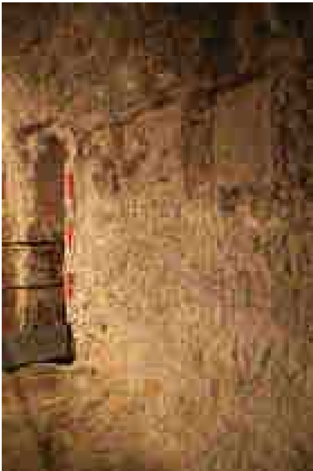
Figura 72: resti del conglomerato del basamento culturale utilizzati come fondazione del muro centrale della cantina.
