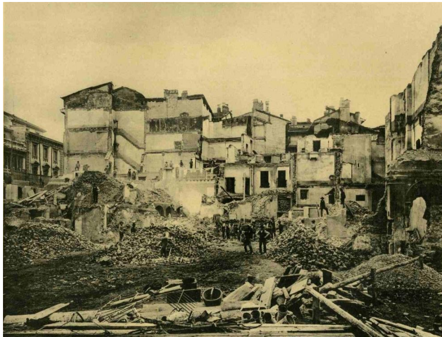
Le demolizioni dell'isolato per la costruzione del nuovo palazzo della Banca d'Italia
