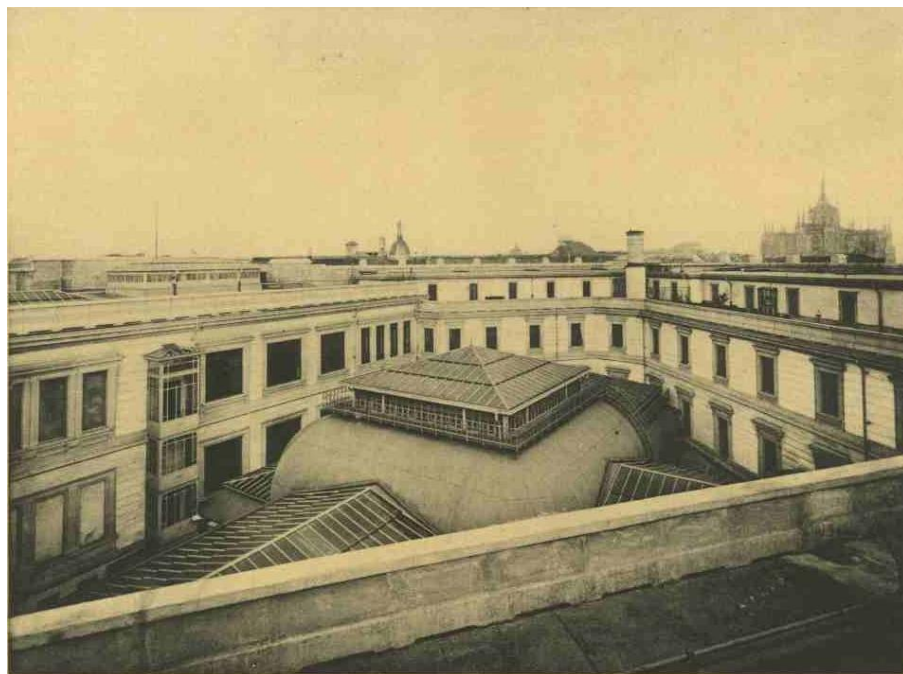
Palazzo della Banca d'Italia, veduta dal cortile interno
