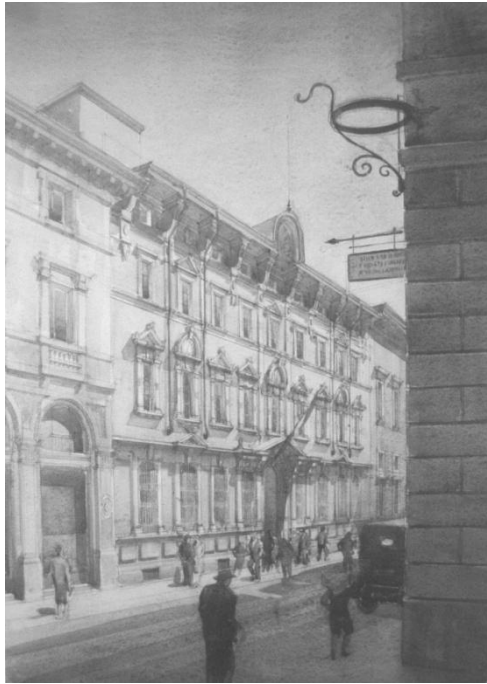
Facciata del palazzo Corio-Casati di via San Paolo, sede della Cassa di Risparmio dal 1851 al 1873 e della Banca Popolare dal 1873 al 1931
