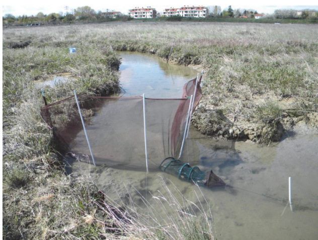
Figura 6. Cogollo in opera all'imboccatura del ghebo
