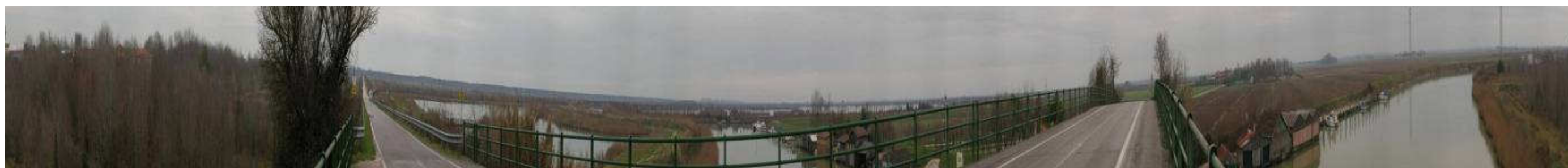
Rilievo fotografico effettuato il 6 gennaio 2009. Punto di rilievo: Valle Vecchia, ponte di accesso
