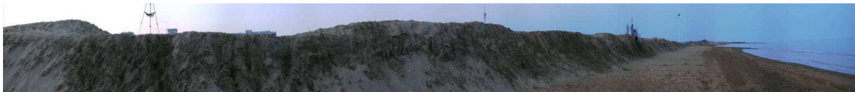
Rilievo fotografico effettuato il 10 aprile 2009 (periodo pre-stagione balneare). Punto di rilievo: arenile
