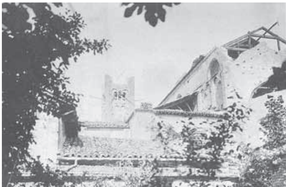
Figure 23. Ravenne, vue de l'église San Francesco en cours de restauration depuis le chevet, 1920. (Benini, 2003, p. 121)
