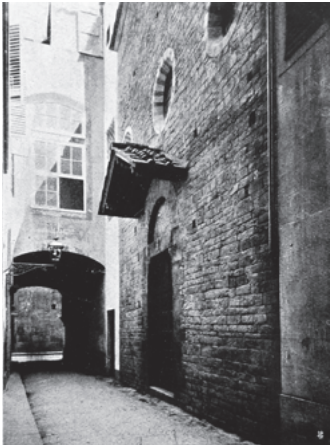
Figure 135. Florence, église Santa Margherita dei Ricci après restauration. ( Bollettino d'arte , II, I, 1922, p. 345)
