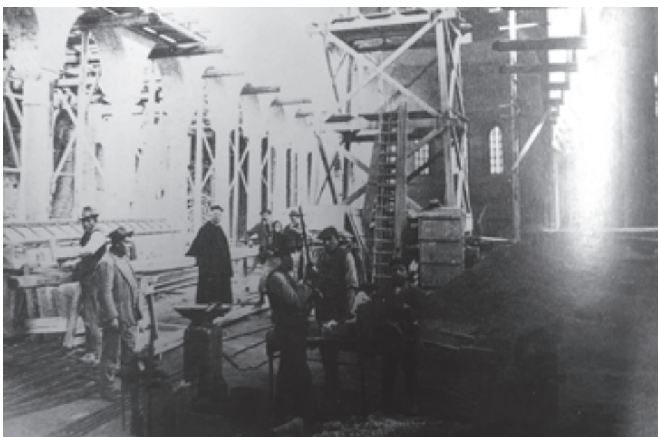
Figure 25. Ravenne, nef de l'église San Francesco durant les travaux, 1920. (Benini, 2003, p. 116)
