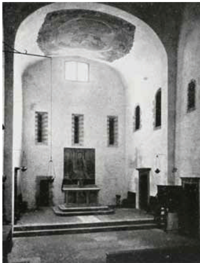
Figure 136. Florence, église Santa Margherita dei Ricci après restauration. ( Bollettino d'arte , II, I, 1922, p. 346)
