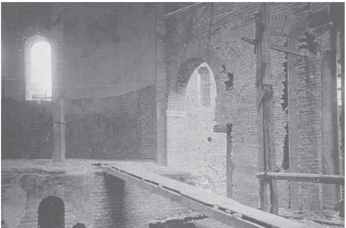
Figure 28. Ravenne, abside de l'église San Francesco durant les travaux, avec la libération de la crypte, 1920. (Benini, 2003, p. 120)
