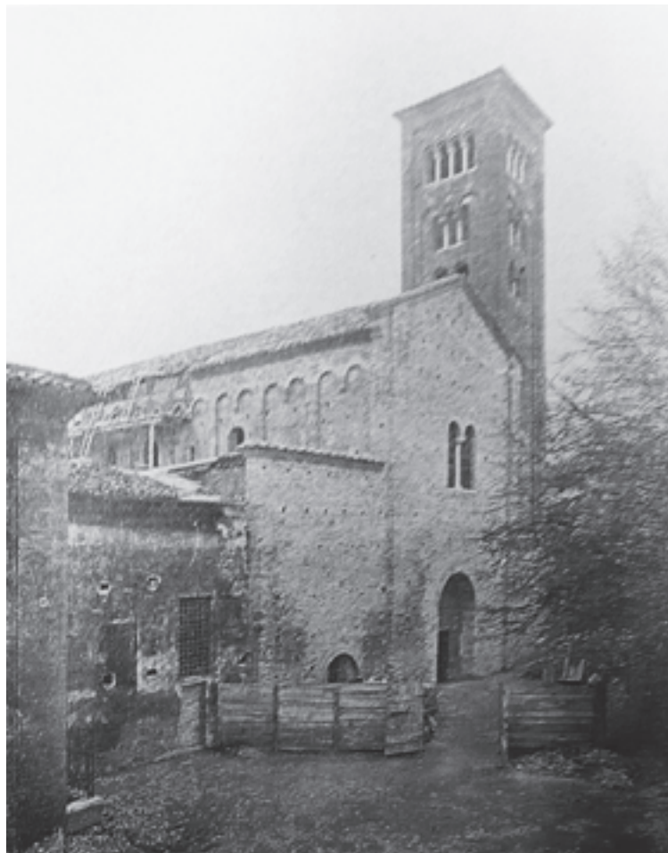
Figure 18. Ravenna, église San Francesco en cours de restauration. La façade est pratiquement achevée, à gauche la chapelle Rasponi n'a pas encore été démolie, ca. 1919-1920. (SBAPR, Archivio fotografico)
