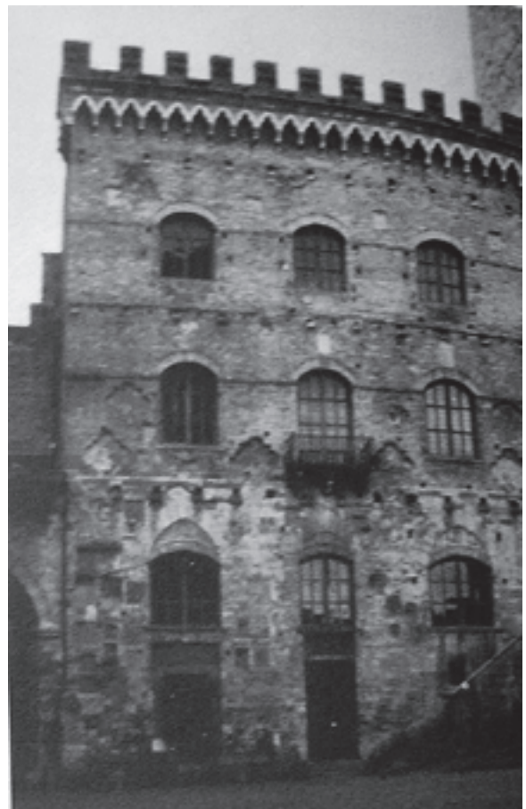
Figure 54. San Gimignano, Casa Salvestrini après restauration. (Masetti, 1985, p. 173)
