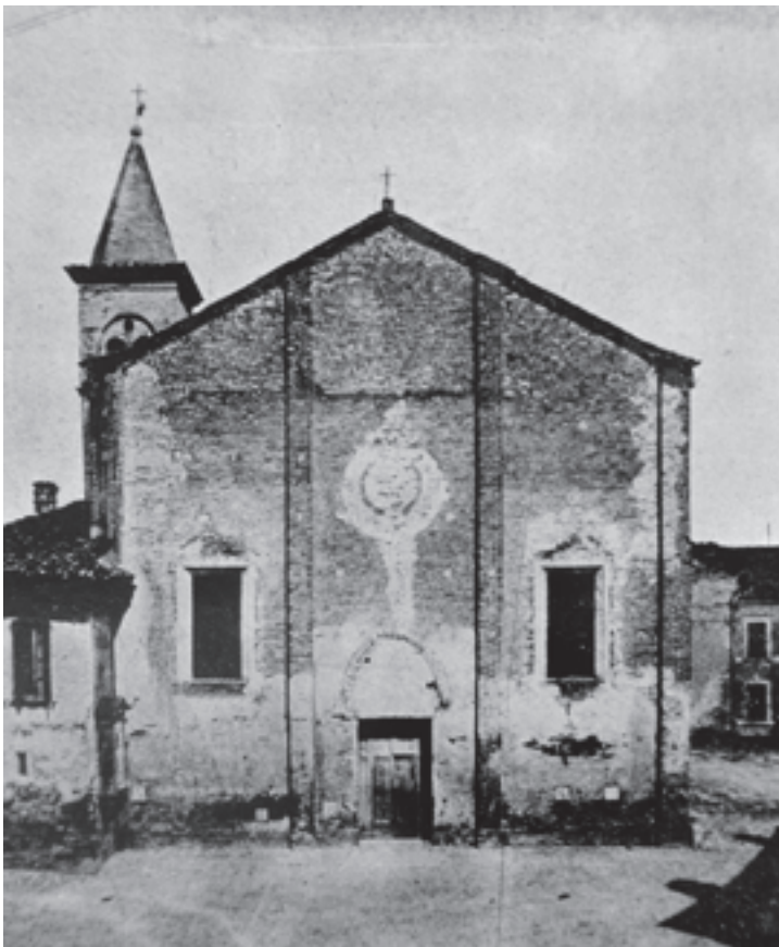
Figure 73. Ferrare, façade de l'église Santa Maria Nuova avant les restaurations, octobre 1920. (Agnelli, 1922, pl. 2)
