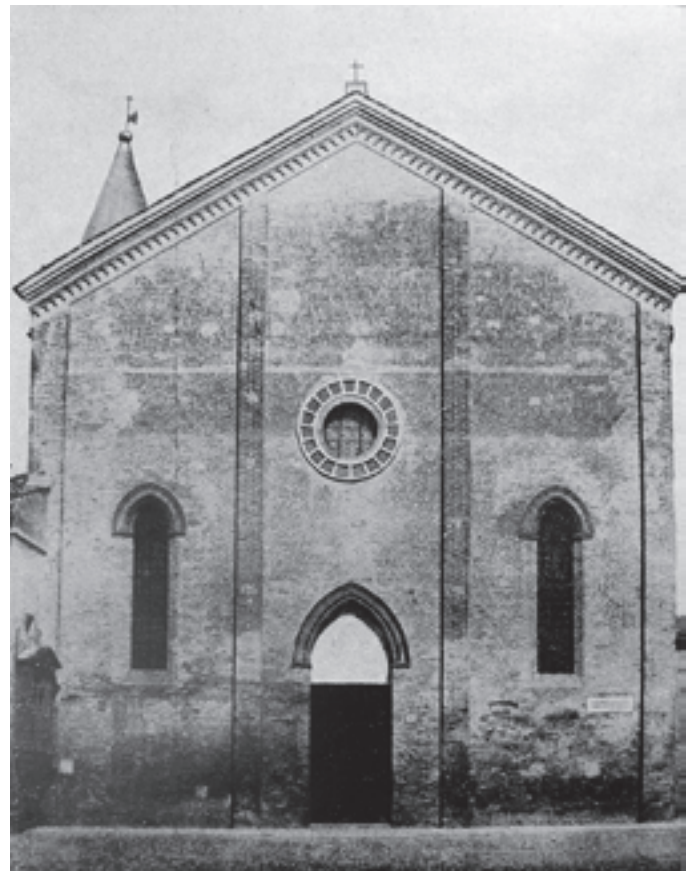
Figure 74. Ferrare, façade de l'église Santa Maria Nuova après les restaurations, décembre 1921. (Agnelli, 1922, pl. 3)
