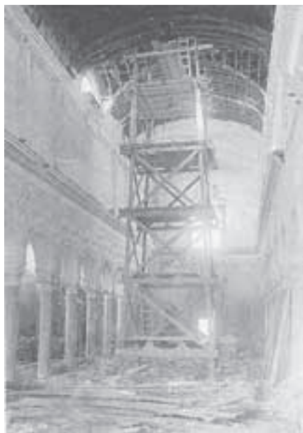
Figure 24. Ravenne, nef de l'église San Francesco durant les travaux, 1920. (Benini, 2003, p. 116)
