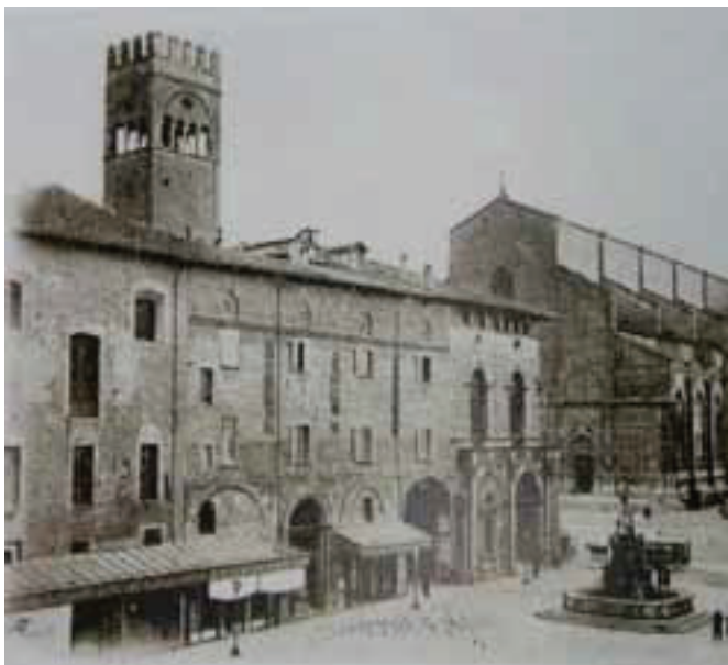
Figure 74. Bologne, Palazzo del Podestà et Palazzo di Re Enzo avant les restaurations du CBSA (Foschi, Giordano, 2003, p. 103).
