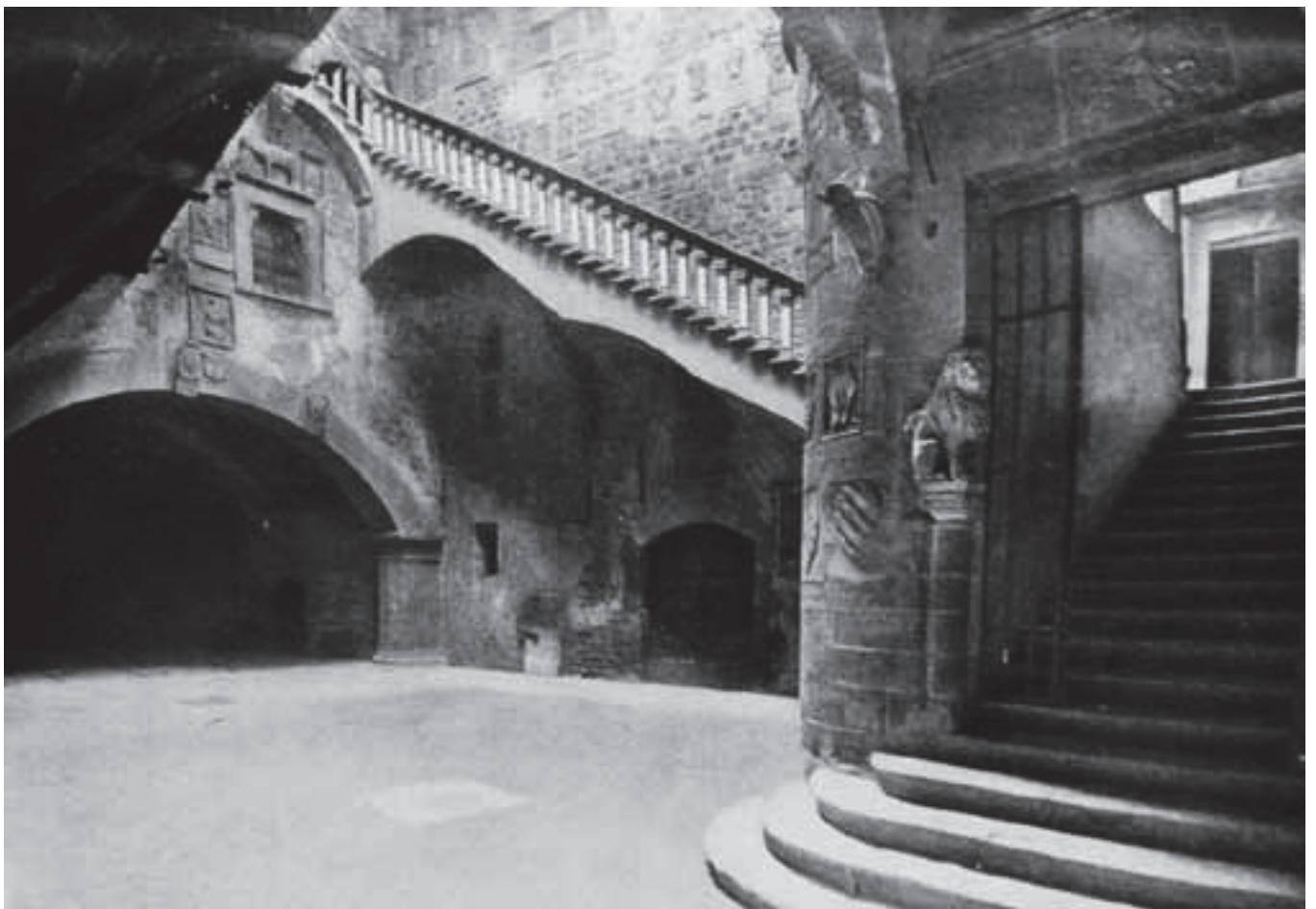
Figure 40. Château de Poppi, cour intérieure après les restaurations. (Lensi, Muratori, Ricci, 1928, p. 309)
