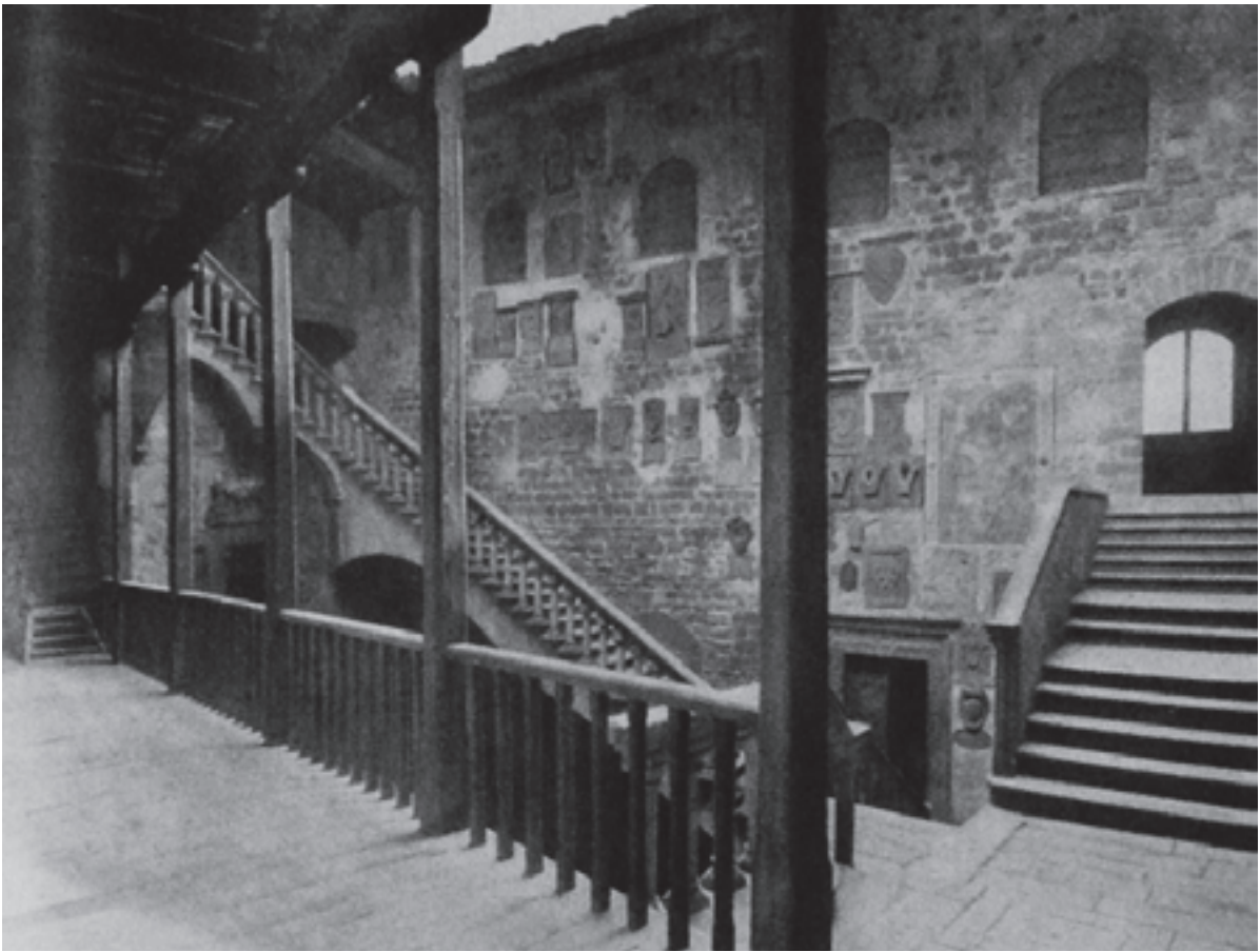
Figure 37. Château de Poppi, intérieur après les restaurations, loggia sur la cour intérieure. (Lensi, Muratori, Ricci, 1928, p. 307)
