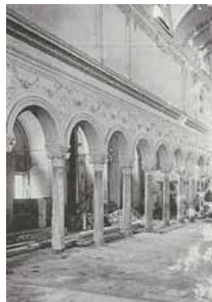
Figure 22. Ravenne, nef de l'église San Francesco durant les travaux, 1919-1920. (Benini, 2003, p. 114)
