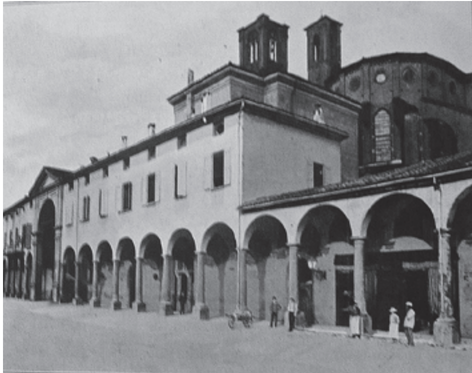
Figure 62. Bologne, vue du chevet de l'église San Francesco et des bureaux de l'ufficio tecnico della R. Intendenza di Finanza, avant le début des travaux en 1888. (Rubbiani, 1899, p. 24)
