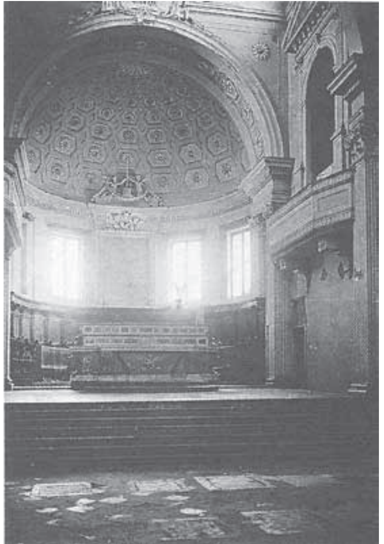
Figure 10. Ravenne, église San Francesco, intérieur avant les restaurations de 1918-1921. (SBAPR, Archivio fotografico)
