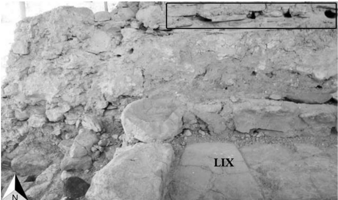
Fig. 3.17 - Parete nord del vano LIX con linea di fori per un solaio, da Sud (foto dell'Autrice).
