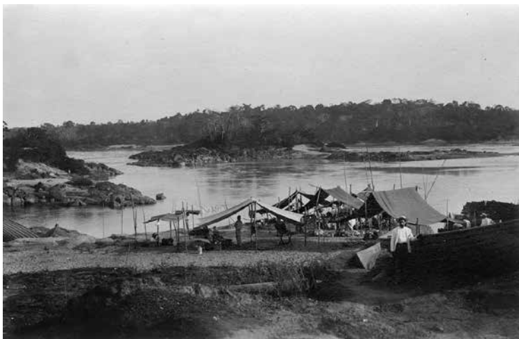
Figura 36. "San Antonio, campamento de batelones de Casa Suárez", 1908-1911, foto de Emil Bauler. Fuente: © Wolfgang Wiggers
