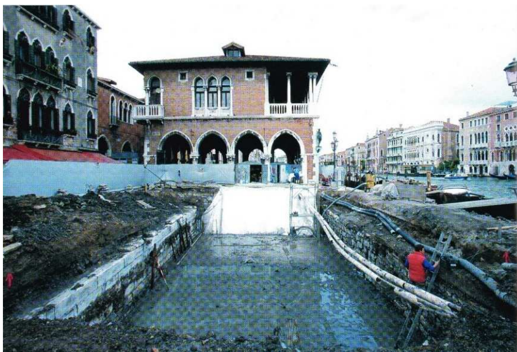
Figura 4.8.2 - Rialto. Veduta delle due rive durante le operazioni di scavo (da BORTOLETTO 2000).
