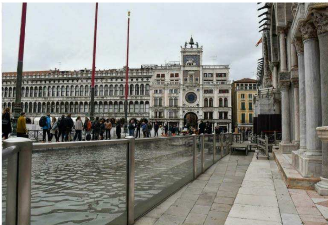
Figura 4.5.1 - PSM-Bas. Struttura in vetro e acciaio per impedire allagamento del Nartece della Basilica di San Marco in funzione (foto da pagina web del Gazzettino). https://projects.pilkington.com/Italy/show/11868/Barriere-in-vetro-a-protezione-della-Basilica-di-San-Marco.aspx
