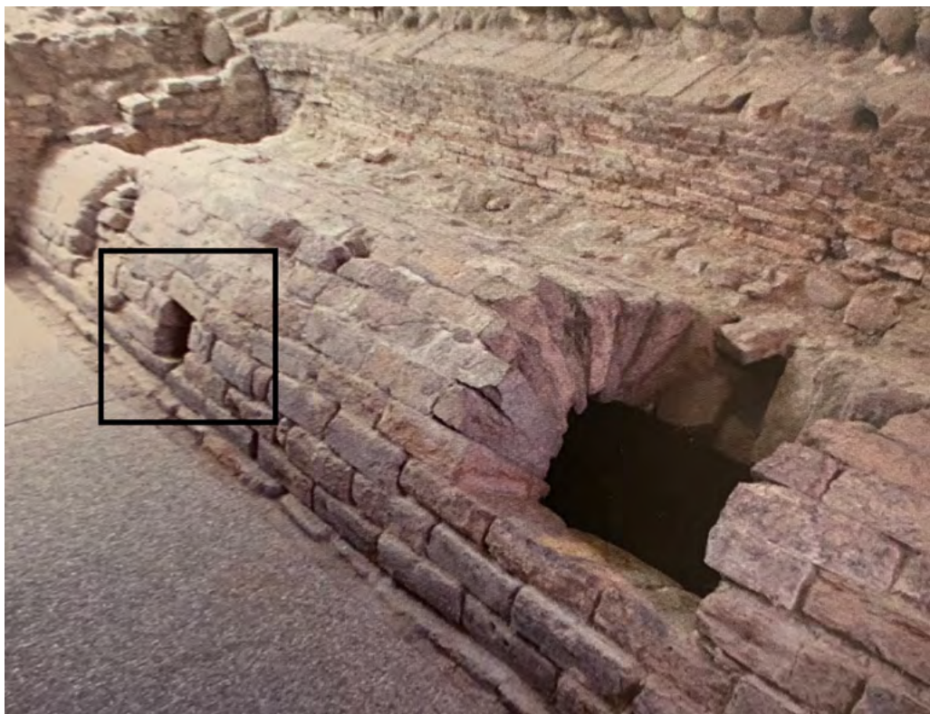
Fig. 2. Punto di innesto di un fognolo laterale all'interno del collettore sotto il kardo 5 (da Bolla 2014, fig. 22).
