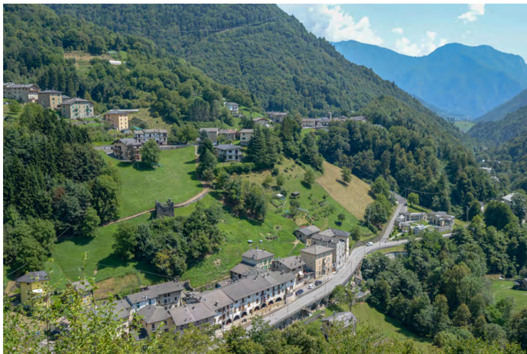
Fig. 2. Averara, veduta della Strada Porticata e della Torre della Fontana dalla Torre sopra la Corna (foto di R. Valente).
