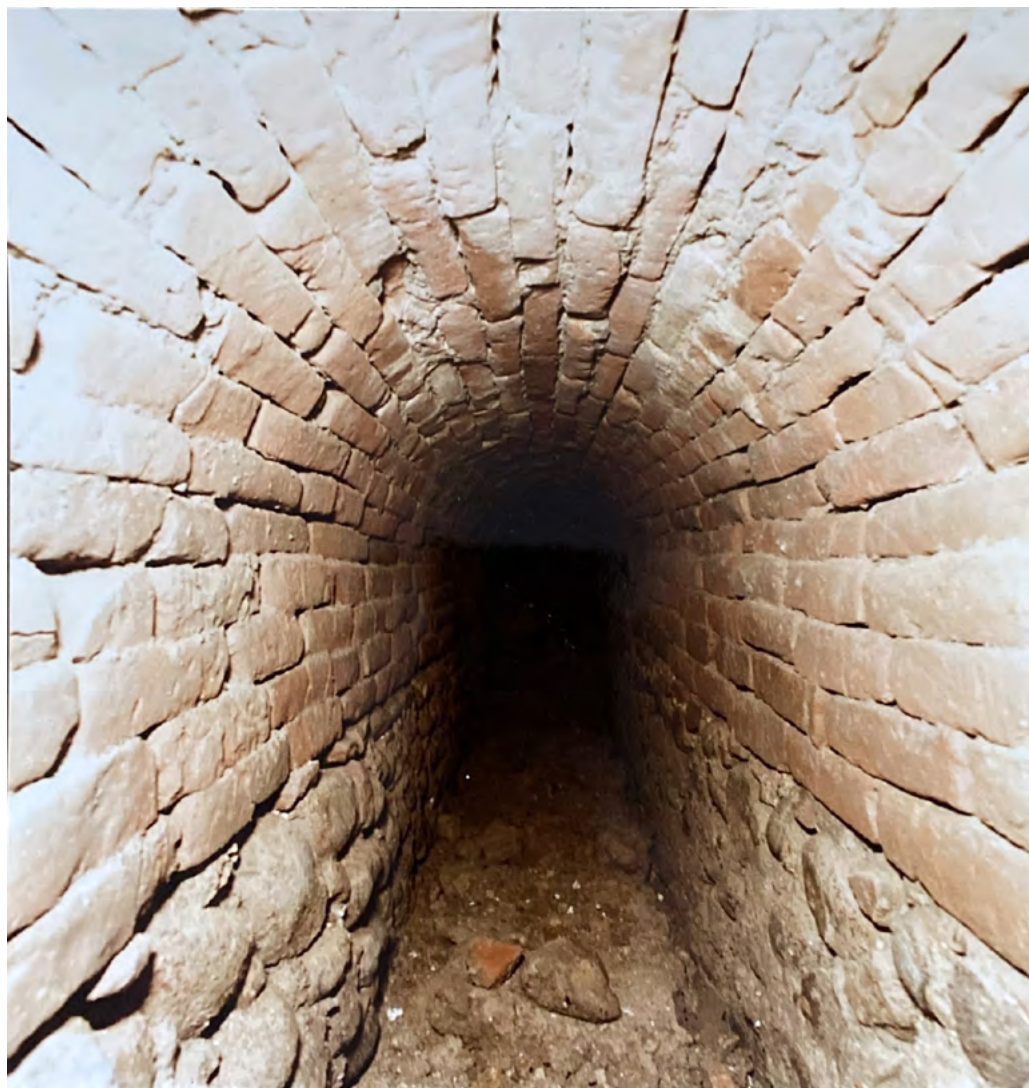
Fig. 4. Condotto fognario a servizio del kardo 3 (su concessione del Mic – Archivio fotografico Soprintendenza Archeologia Belle Arti e Paesaggio per le province di Verona, Rovigo e Vicenza.).
