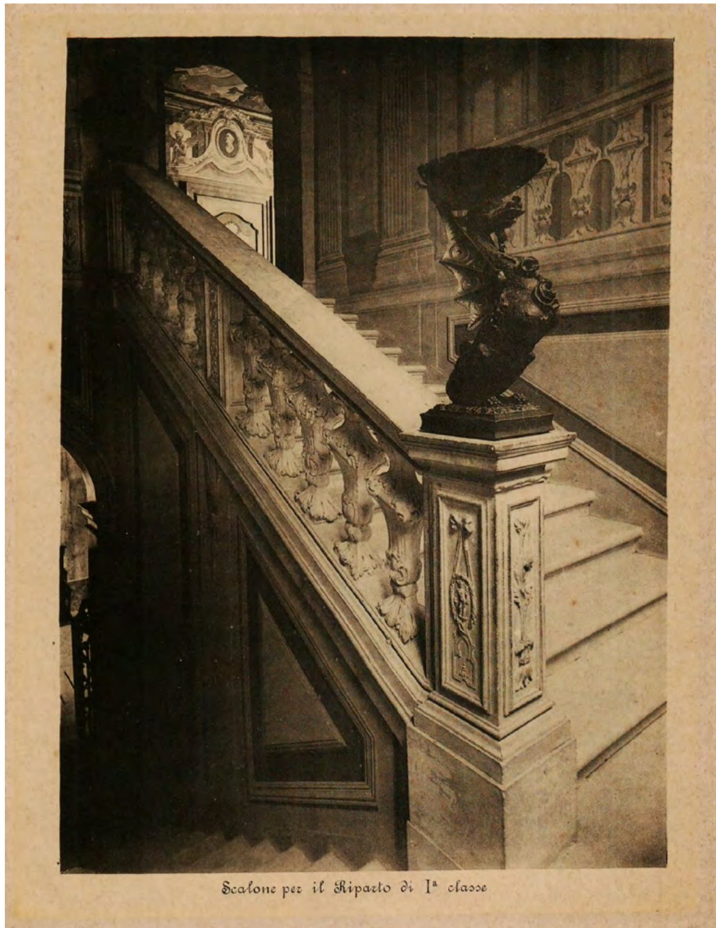
Fig. 1. Scalone per il reparto di Iª classe (da Casa di Cura del Prof. Y. Arslan. Padova ).
