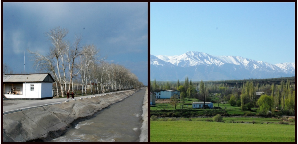
Fig. 10.2 – Regione di Samarcanda, Uzbekistan: un canale di derivazione dalla Diga del 1° Maggio (sx), area pedemontana del Chakilayan (dx)
