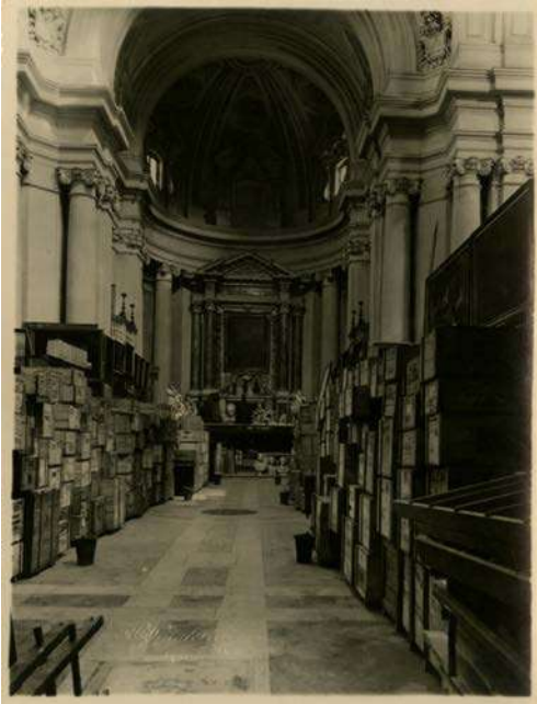
Fig. 11a. Roma, Opere della collezione dell'Accademia di San Luca in deposito nella Chiesa dei Santi Luca e Martina, Foto Luglielli 1931, AASL, Miscellanea Fotografie.
