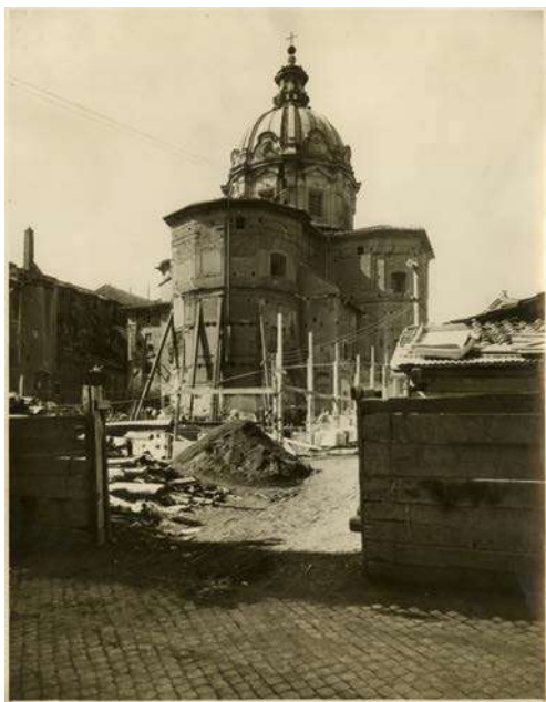
Fig. 9c. Lavori di demolizione e ricostruzione della sede dell'Accademia di San Luca in Via Bonella, 1932, AASL, Miscellanea Fotografie.
