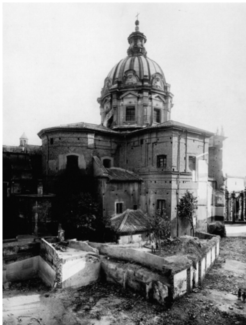
Fig. 9b. Lavori di demolizione e ricostruzione della sede dell'Accademia di San Luca in Via Bonella, 1932, AASL, Miscellanea Fotografie.
