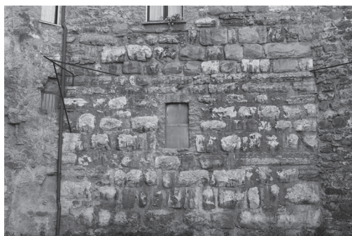
Fig. 17. Cividate Camuno. Particolare della tessitura muraria della Torre Lanfranchini in cui si notano in condizione di reimpiego elementi di rocchi di colonne in granito.
